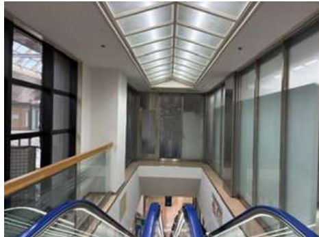
西国分寺レガ 天井照明更新
