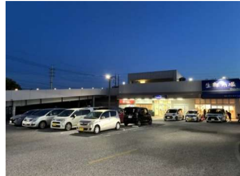
しいの木台ショッピングプラザ外部照明更新
